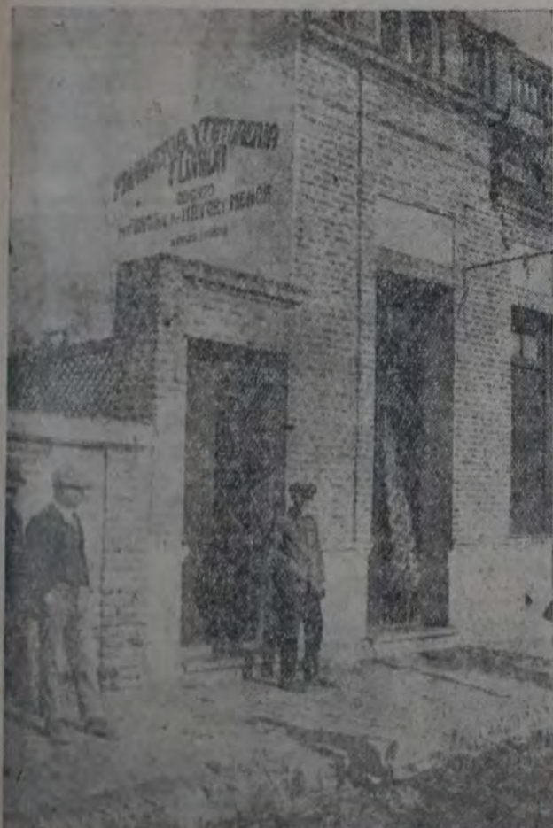
UNA DE LAS CASAS DE LA CALLE FLORIDA, EN VALENTIN ALSINA, tiroteada por los "brigantes"
